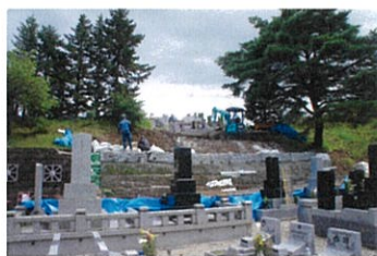
法面改修工事
