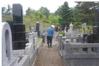
地割れ箇所締固め・転圧工事
