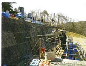
西10区擁壁補修工事
