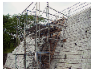
擁壁改修工事
