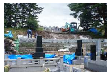
法面改修工事
