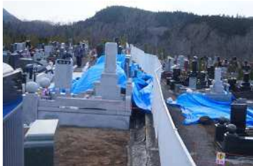
擁壁破損
