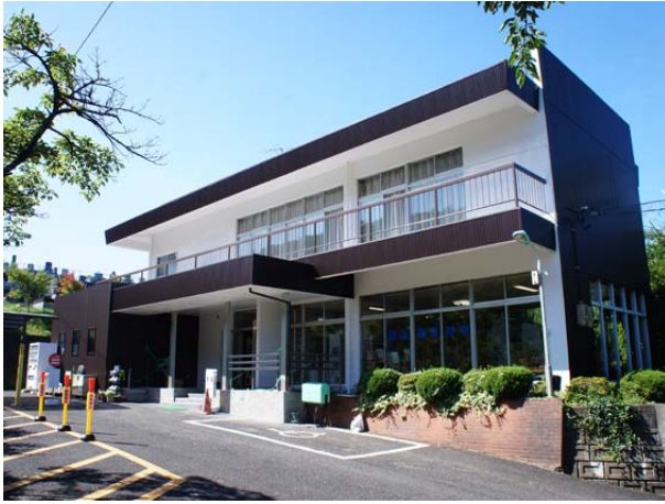
管理棟外壁改装
